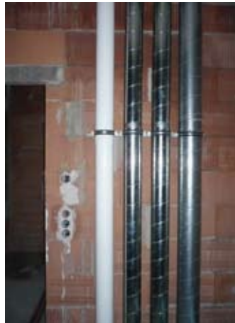
Bild 2 a und b: Ein Standard-Sachmangel: Doppelrohrsystem (LAS/AZ) im Installationsbereich ohne klassifizierten Schacht; ...
